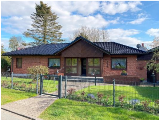
Abbildung 7-26: Mustersanierungsobjekt 3, Vorderansicht, Foto: FRANK
