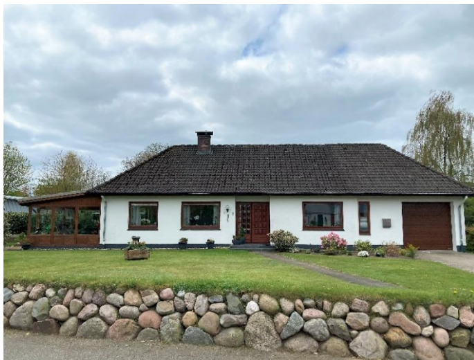
Abbildung 7-1: Mustersanierungsobjekt 1, Vorderansicht. Foto: FRANK
