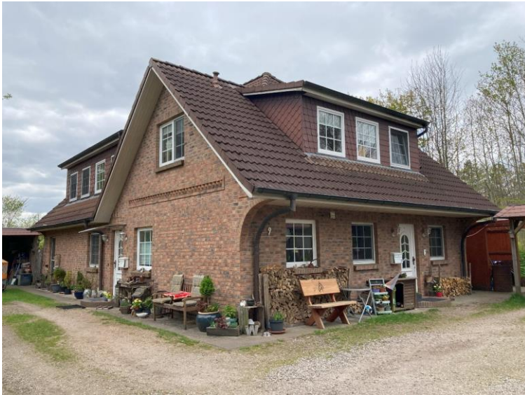
Abbildung 7-13: Mustersanierungsobjekt 2, Vorderansicht, Foto: FRANK
